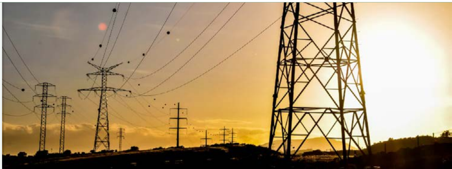
TORRES DE DISTRIBUIÇÃO DE ENERGIA. FOTO: ADOBE STOCK
