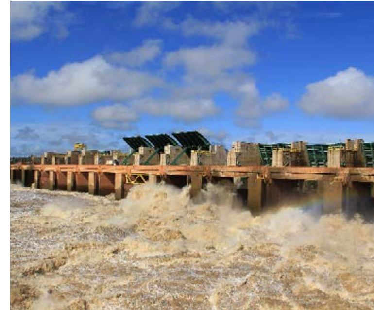
VERTEDOURO. FOTO: SANTO ANTÔNIO ENERGIA
